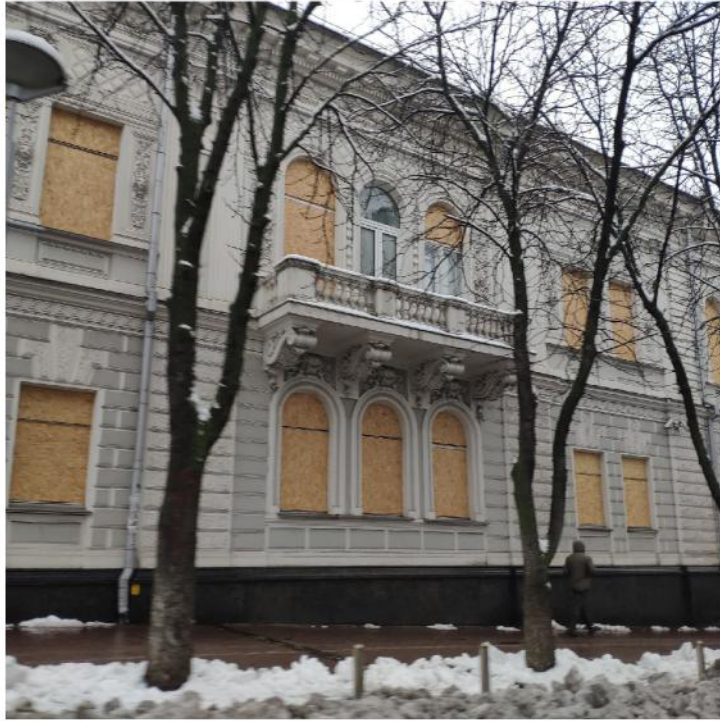
Kyiv, Taras Schewtschenko Museum. Fensterabdeckung mit OSB-Platten nach dem Drohnen-Beschuss der Innenstadt am 10.10.2023
